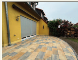
■ Der Terrassenbau ist eine der Spezialitäten des Unternehmens.
