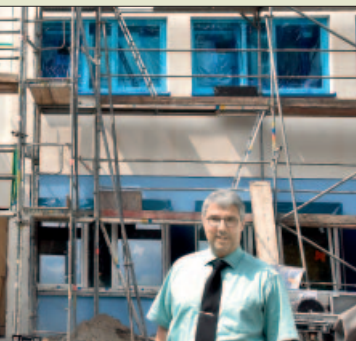
■ Wie hier an der Robinson-Grundschule wird aufgestockt, um mehr Raum zu bekommen. (Foto I.)
